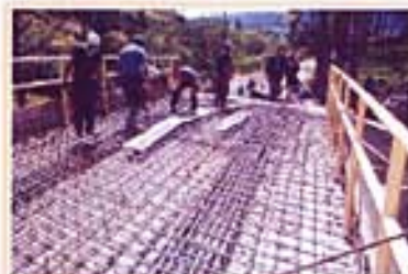
Construção de uma ponte (Peru)
